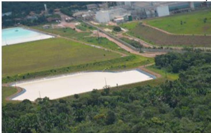
FIGURA 24 e 25. Bacia de rejeito Nº 3
